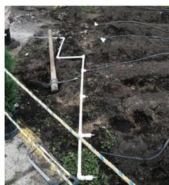
**9e. Conexión tubo PVC con manguera de riego.**
